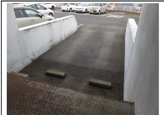
①配膳室出入口（物資置き場）
