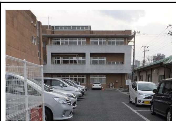
⑤関係車両駐車スペース（北側）
