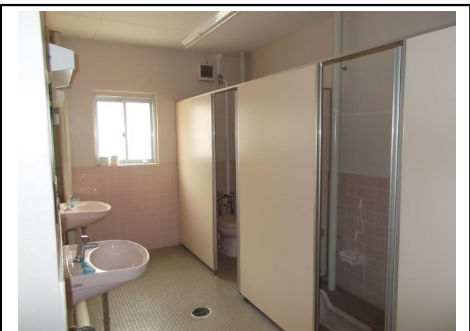
⑧体育館トイレ（女性）
