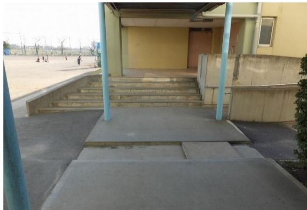
③情報掲示板設置場所
