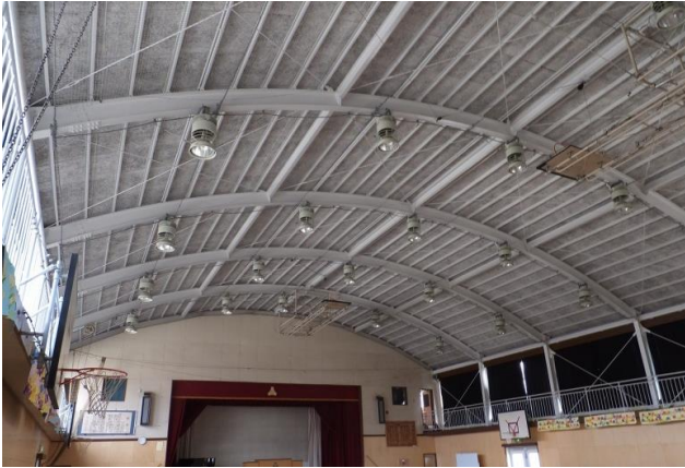
③ 体育館天井(1)
