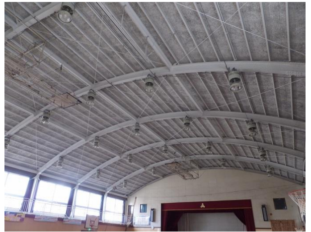
④ 体育館天井(2)
