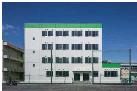
（増築校舎外観）
