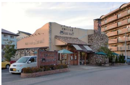
石窯パン工房 KIEEBIAtt 若草店 第2回福岡県屋外広告景観賞 福岡県大野城市
