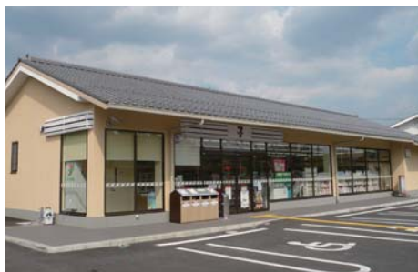
セブンイレブン京都福王寺店 平成20年度京都市優良屋外広告物賞 京都府京都市右京区
