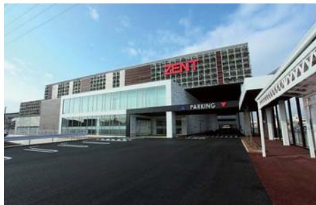
ZENT市ノ坪店 平成26年度岐阜市景観賞 岐阜県岐阜市
