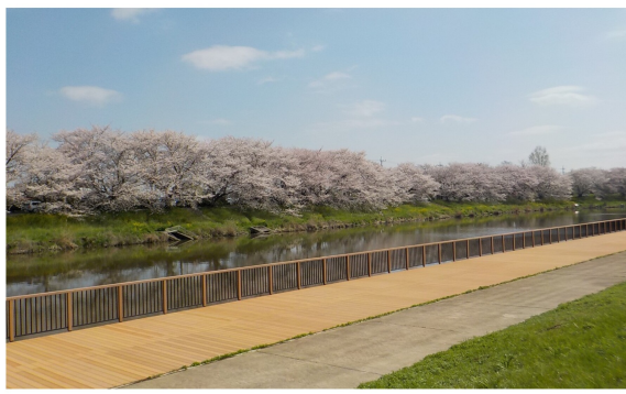
びん沼川沿いの河川デッキ
