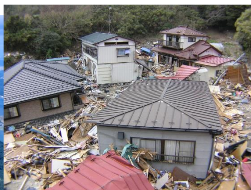
月浜の被害状況
