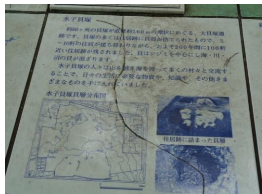
図120 大型説明板破損状況
