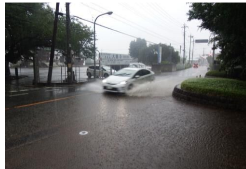
図 124 公園北側の市道の冠水状況
