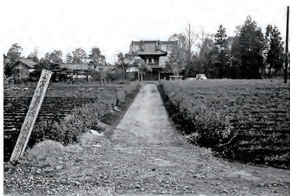
第3次調査の頃(昭和42年)の大応寺付近
