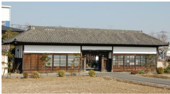
大澤家長屋門(平成 19 年) 部屋が設けられているのが分かる
