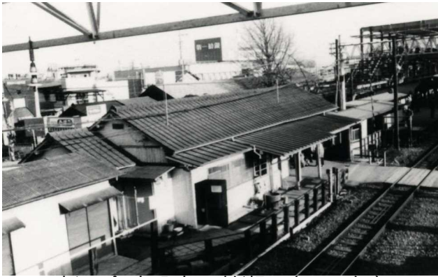
新駅舎建設中の鶴瀬駅 (1973年)
