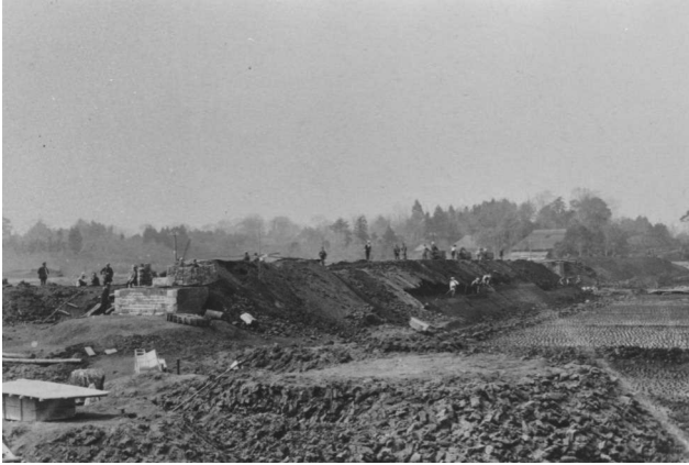
東上線敷設工事(1914年)
