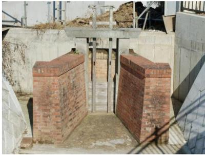
明治37年(1904)に、氷川排水に新河岸川からの逆流を防ぐために造られた煉瓦製の樋門。通水口の断面形は箱状、扉は引上げ式。煉瓦の積み方はイギリス積みと呼ばれるもので、上端部は意匠性を出している。水路工事に伴い現在の場所に移設した。
