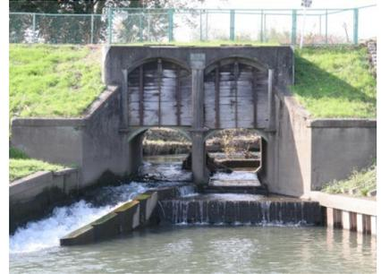
大正～昭和にかけての新河岸川改修の際に建造されたコンクリート製の樋管。この河川改修の建造物として現存する唯一のもの。昭和2年(1927)建造。
