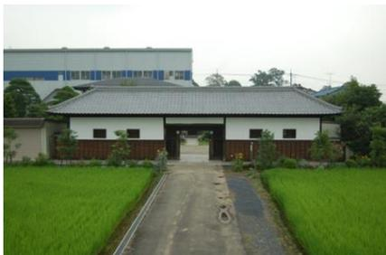
建築年代は不明だが、慶応2年(1866)の武州一揆の際につけられたという刃物の傷が柱に見られることから、それ以前の建築と推定される。桁行10.5間、梁間2間の木造平屋建て、屋根は寄棟造の棧瓦葺。戦前に一部改築されたが、平成19年(2007)の改修で、建築当初の姿に戻した。
