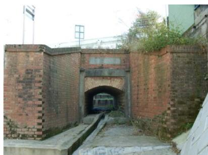
明治37年(1904)に、水越排水に新河岸川からの逆流を防ぐために造られた煉瓦製の樋門。通水口の断面形はかまぼこ状のアーチ型、扉は観音開き構造。煉瓦の積み方はイギリス積みと呼ばれるもので、通水口上のアーチと上端部は意匠性を出している。表側に「水越門樋」、裏側に「明治三十七年二月」の銘板がつけられている。
