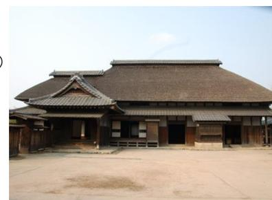
旧大澤家住宅は、棟札により明治4年(1871)に建築され、主屋は桁行12.5間、梁間4間の木造平屋建で屋根は寄棟造の茅葺、玄関は入母屋造の棧瓦葺。当時の民家としてはかなり大規模なもので、「式台」といわれる玄関は、名主の家として高い格式や役宅としての特徴を表している。現在は、難波田城公園内に移築された。
