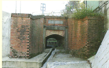
⑤水越門樋（建造物） 明治 37 年(1904)に旧新河岸川堤に設置された煉瓦造りの樋門です。
