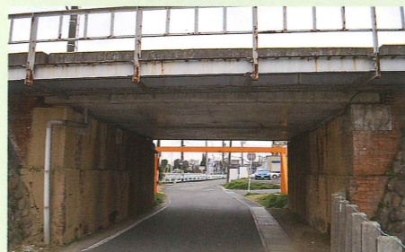
⑩煉瓦造り橋脚（建造物） 東上線の敷設時に建造されました。
