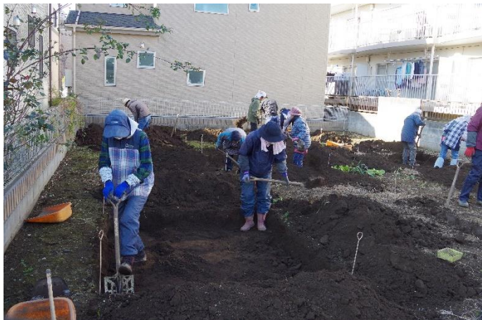
人力で表土を掘削していきます
