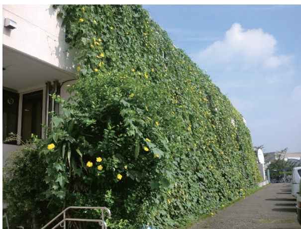
庁舎の壁面緑化
