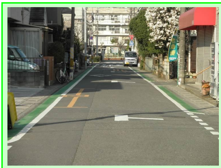
通学路のグリーンベルト施工
