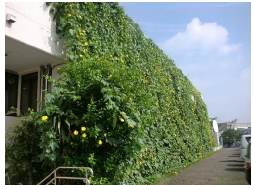
庁舎の壁面緑化
