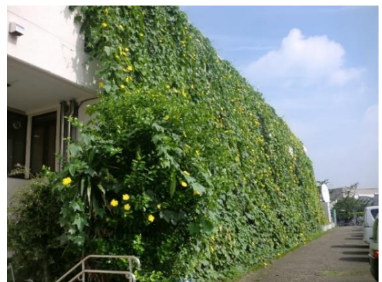
庁舎の壁面緑化
