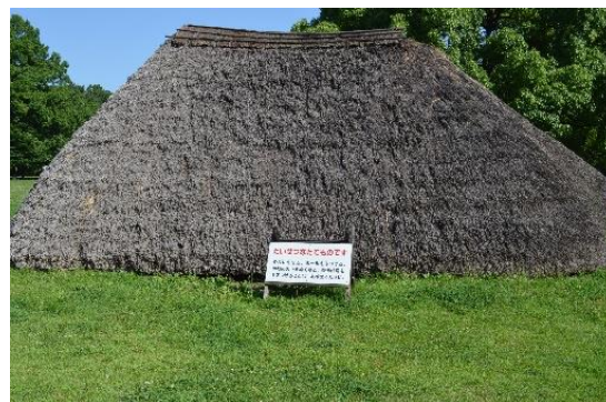
第 88 図 注意喚起看板の設置
