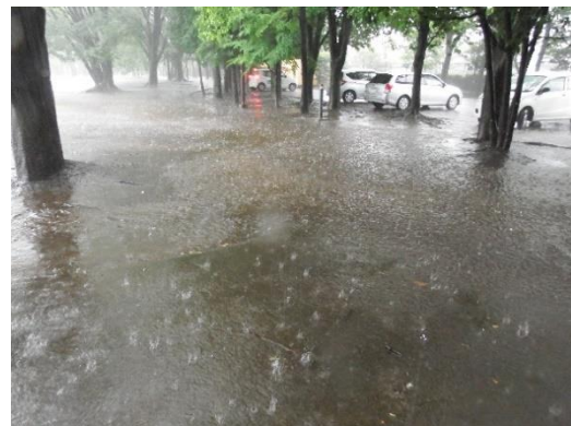
第 80 図 雨水で水没した園路
