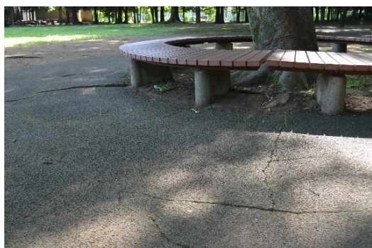
第75図 根上りにより破損した園路
