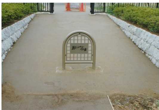
第74図 整備当初の園路（左）と改修後の着色透水性コンクリートの園路（右）
