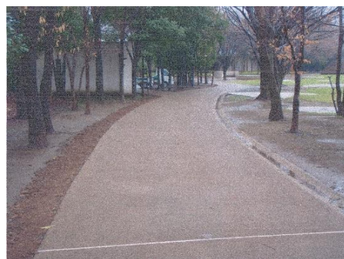
第74図 整備当初の園路（左）と改修後の着色透水性コンクリートの園路（右）
