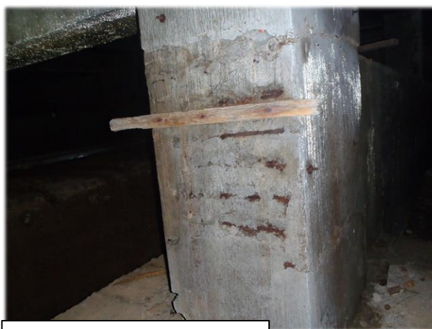
参考写真②（基礎鉄筋露出）
