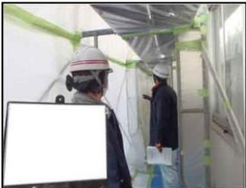
② 専用の負圧除塵装置を設置し作業空間内を負圧にします
