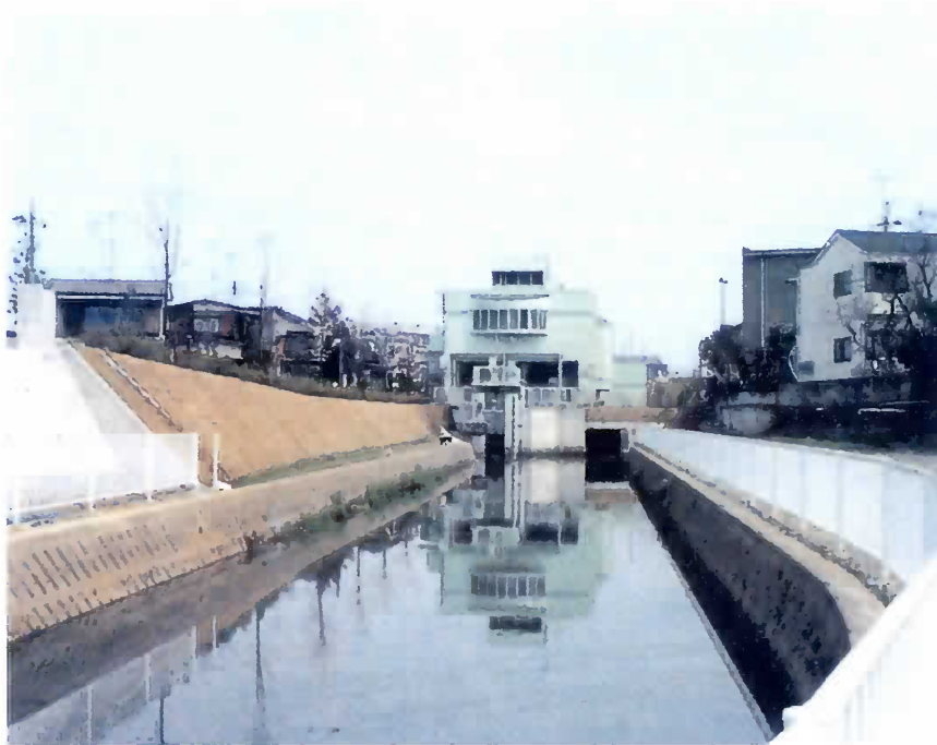
別所雨水ポンプ場
