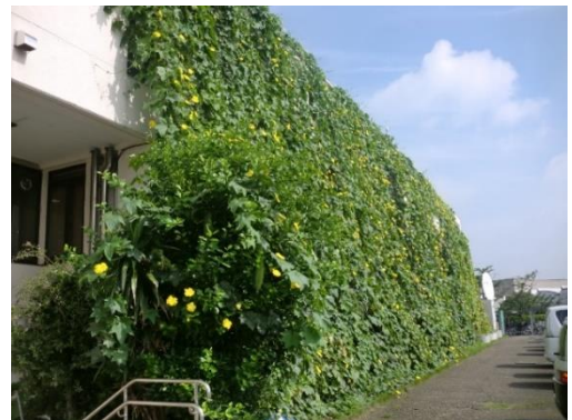
庁舎の壁面緑化
