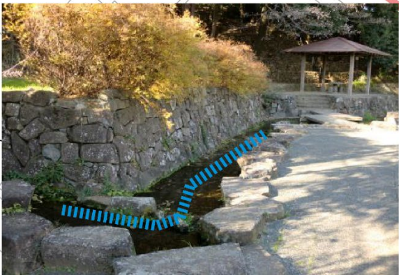
整備済水路を浚渫
