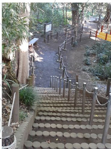
既存園路から整地と柵の設置 による園路整備
